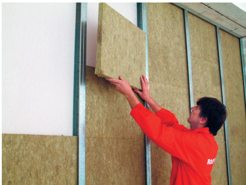
**Рисунок 18. Установка Rockwool Акустик Баттс в перегородку**
